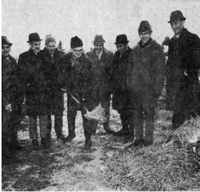
Pelletée de terre de J.-Conrad Cayer, président de la CECS, inaugurant le début des travaux de construction, 15 février 1971. ( La Tribune , 16 février 1971, p. 5)
