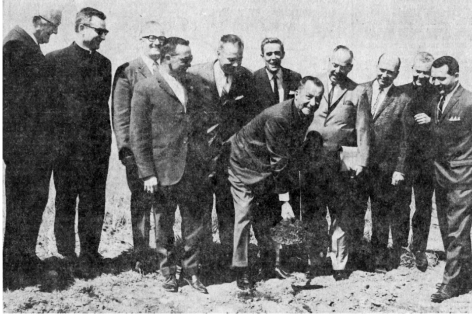
Pelletée de terre du président de la CECS, François Thibault, inaugurant le début des travaux de construction, 24 mai 1966. ( La Tribune , 25 mai 1966, p. 5)
