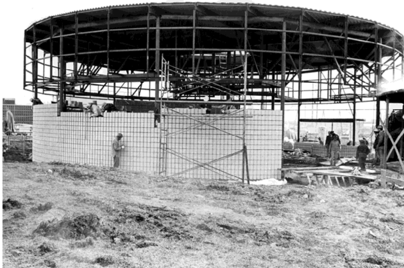
Chantier de l'école secondaire Montcalm, 1963. (Collection de la Société d'histoire de Sherbrooke, ISI)
