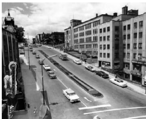
Le bâtiment de la rue King Ouest accueille l'École secondaire Saint-Michel de 1959 à 1975, vers 1959.
