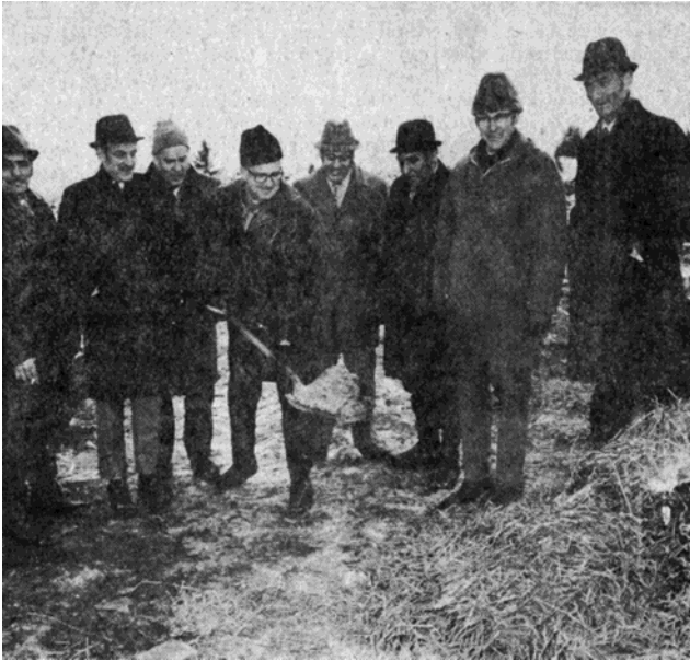
Pelletée de terre de J.-Conrad Cayer, président de la CECS, inaugurant le début des travaux de construction, 15 février 1971. ( La Tribune , 16 février 1971, p. 5)
