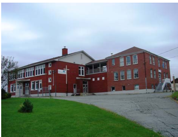
L'école Notre-Dame-de-la-Paix, août 2010. On voit bien les différentes sections de l'école : la partie de droite correspond à l'ancienne école, alors que la section de gauche ainsi que le passage ont été construits en 1957-58. (Photo par Alexis Dubois-Campagna, CSRS)
